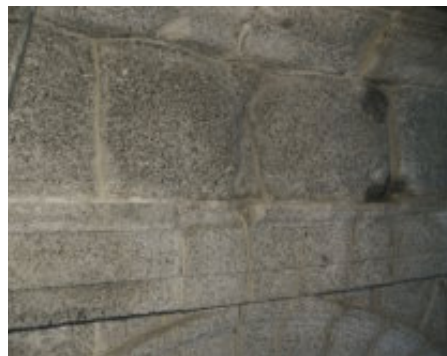
FIGS. 28 y 29 Detalle del estado de la cantería antes y después de la restauración
