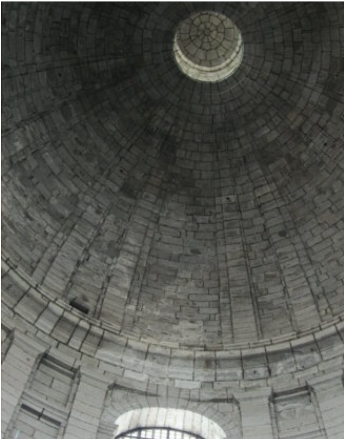
FIG. 22 Vista general del cimborrio de la Basílica antes de la restauración
