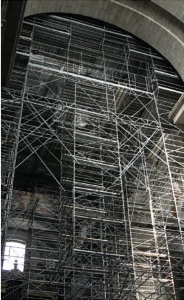
FIG. 27 Andamios instalados en el interior de la Basílica
