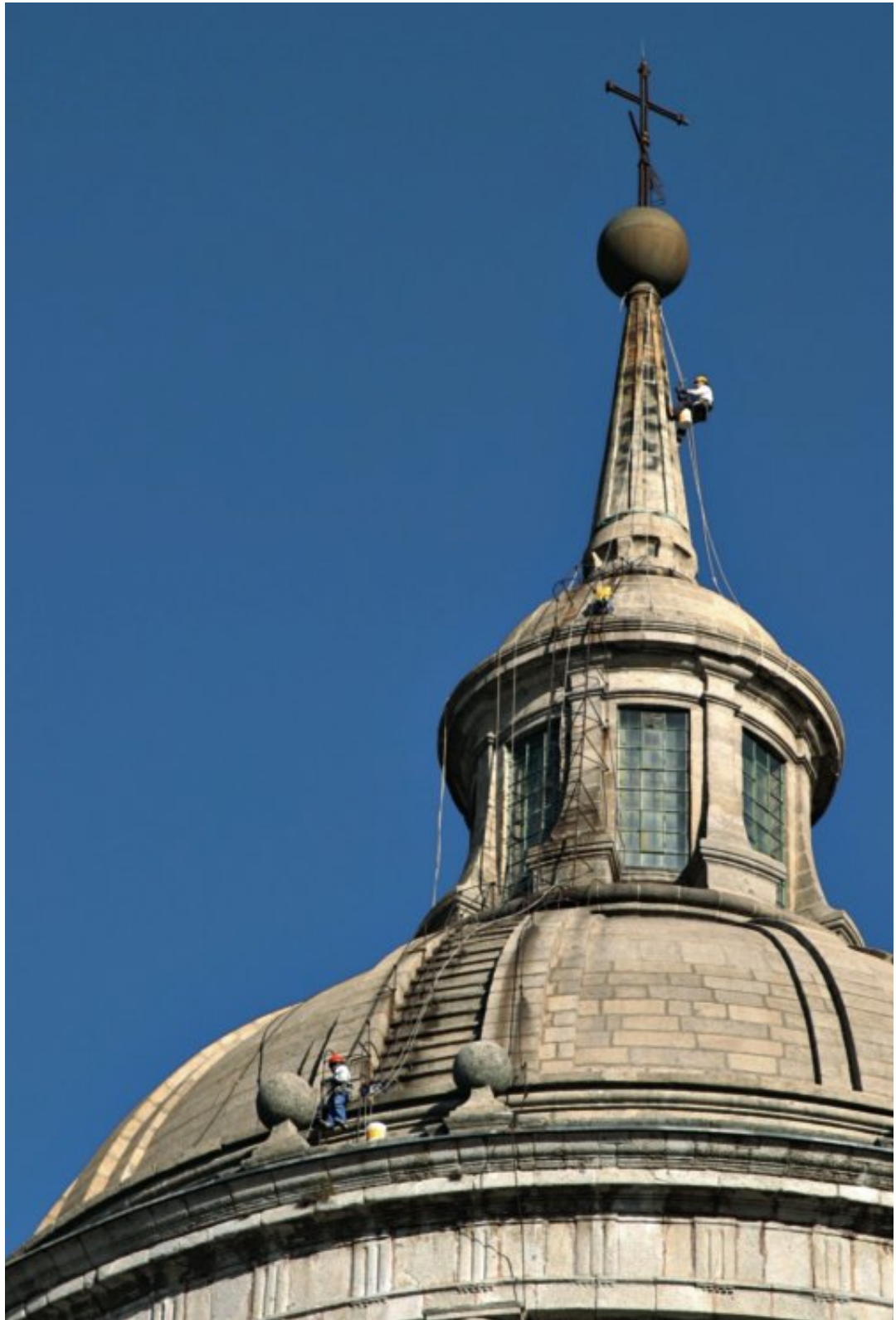
FIG. 26 Ejecución de los trabajos en la linterna y cúpula de la Basílica
