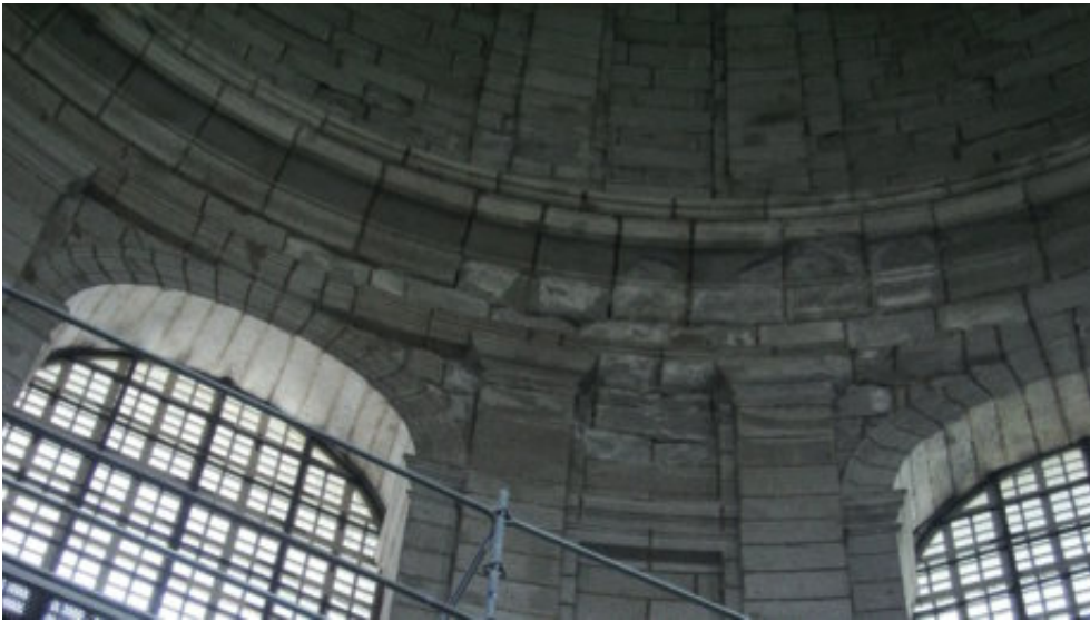
FIG. 25 Estado de la cantería en el tambor de la cúpula de la Basílica con anterioridad a las obras de restauración
