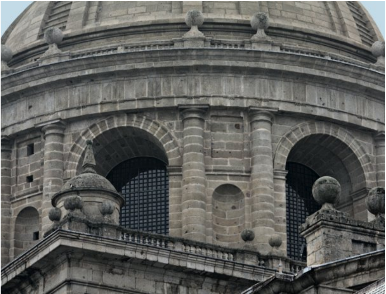
FIG. 30 Estado del tambor de la Basílica al finalizar las obras
